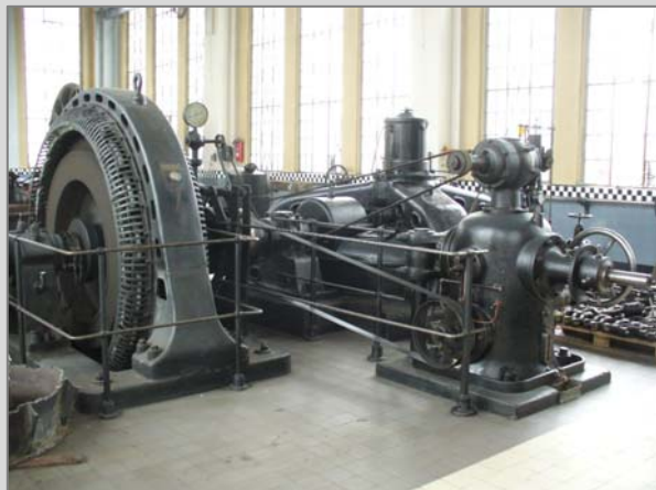
Pohled do haly elektrárny na zbývající soustrojí
