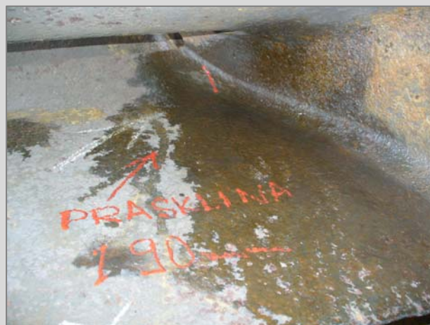
Trhlina vetknutí mezi OL a nábojem zjištěná MT kontrolou
