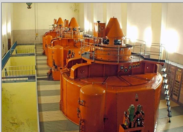
Pohled do stávající strojovny VE Doblar 1
