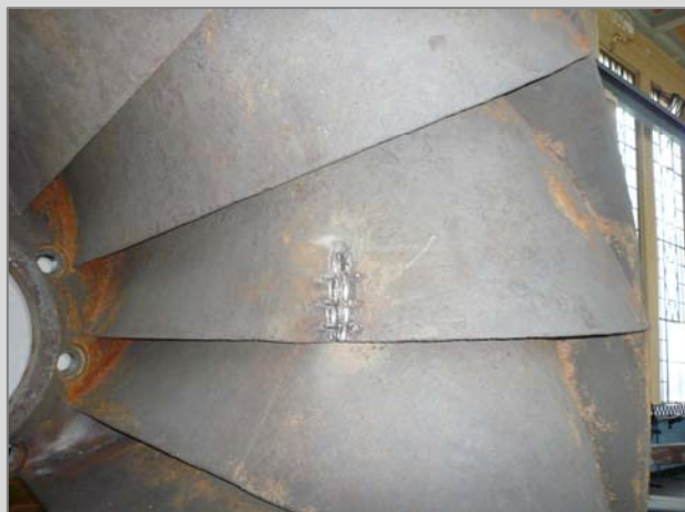
Oprava prasklé výstupní hrany OL
